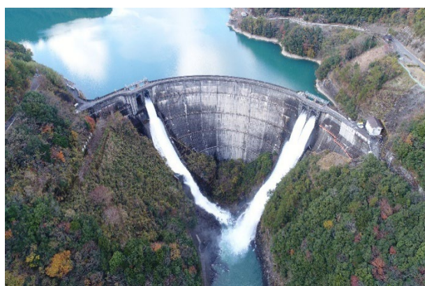
上椎葉発電所（宮崎県）
