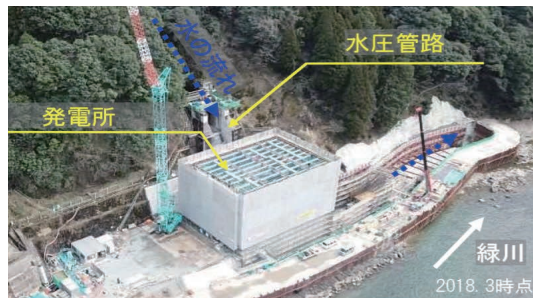
工事も大詰めを迎えている新甲佐発電所の開発状況
