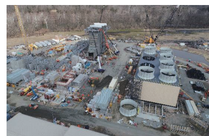
建設中のバースボローガス火力発電所
