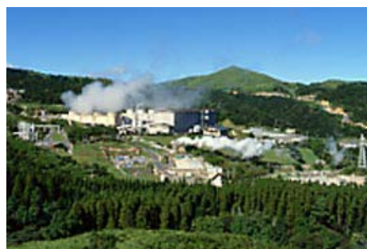
八丁原発電所（大分）
