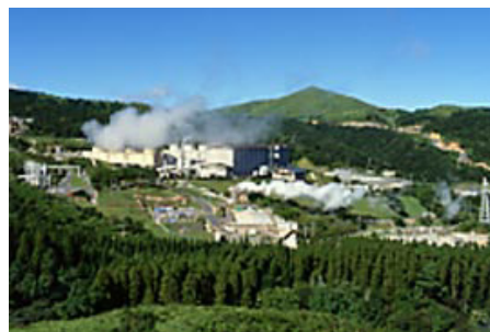
八丁原発電所（大分）
