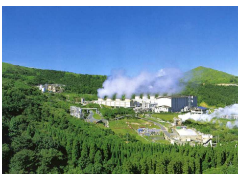
八丁原発電所（大分）
