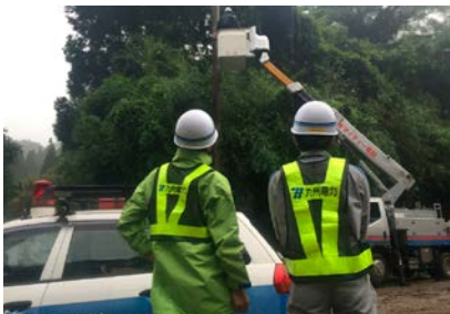
九州北部豪雨復旧作業
