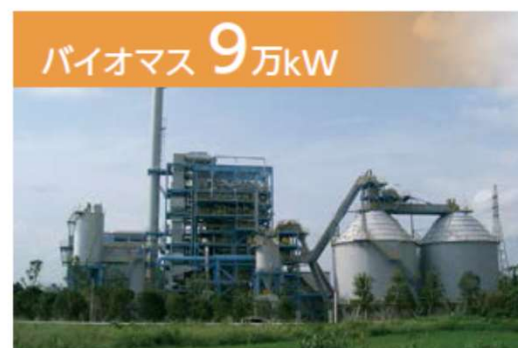
バイオマス 9万kW みやざきバイオマスリサイクル発電所(宮崎県) 設備容量: 11,350kW 操業開始: 2005年5月
