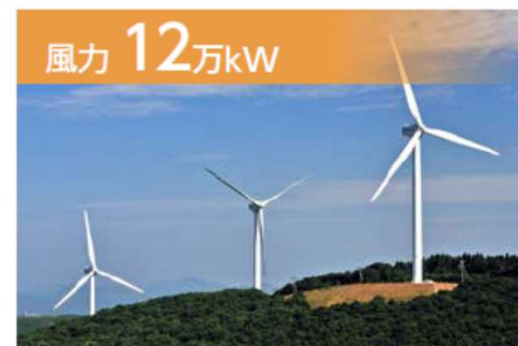
風力 12万kW 長島風力発電所(鹿児島県) 設備容量: 50,400kW 操業開始: 2008年10月
