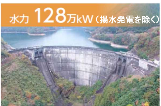
水力 128万kW (揚水発電を除く) 上椎葉発電所(宮崎県) 設備容量: 93,200kW 操業開始: 1955年5月
