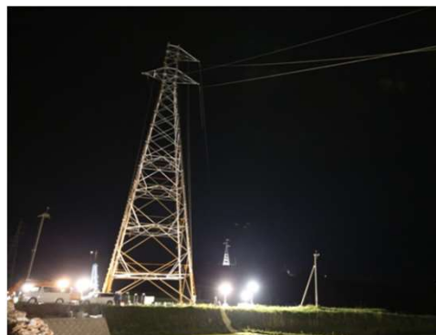
[仮鉄塔建設作業]
