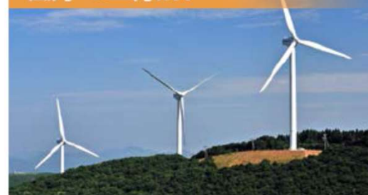
長島風力発電所(鹿児島県) 設備容量：50,400kW 操業開始：2008年10月
