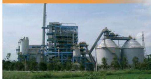
みやざきバイオマスリサイクル発電所(宮崎県) 設備容量：11,350kW 操業開始：2005年5月
