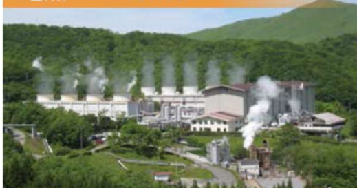
八丁原発電所(大分県) 設備容量：110,000kW(55,000×2) 操業開始：1977年6月
