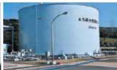
② 代替水源のタンク
