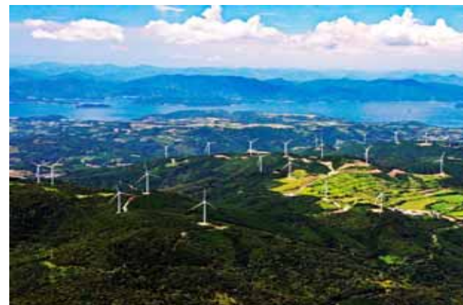
【長島風力発電所】
