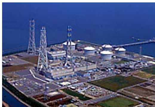
新大分発電所（大分）
