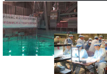
使用済燃料ピットラックセル点検(水中カメラ)
