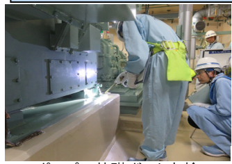
ポンプの基礎ボルト点検
