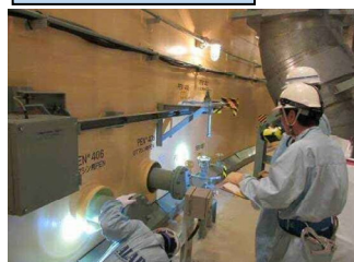
格納容器貫通部点検
