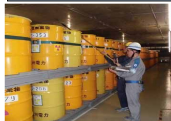
保管容器の固縛状態点検
