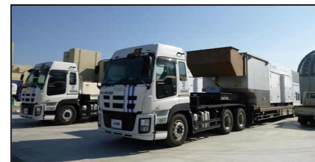
◇大容量発電機（発電所構内）
