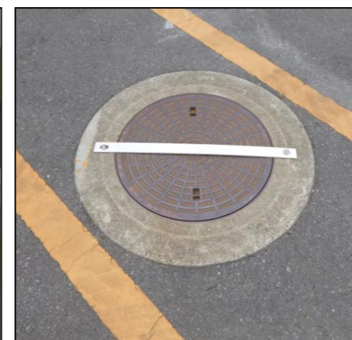
マンホール蓋の固定
