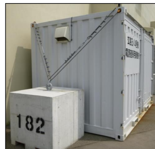
資機材の固縛
